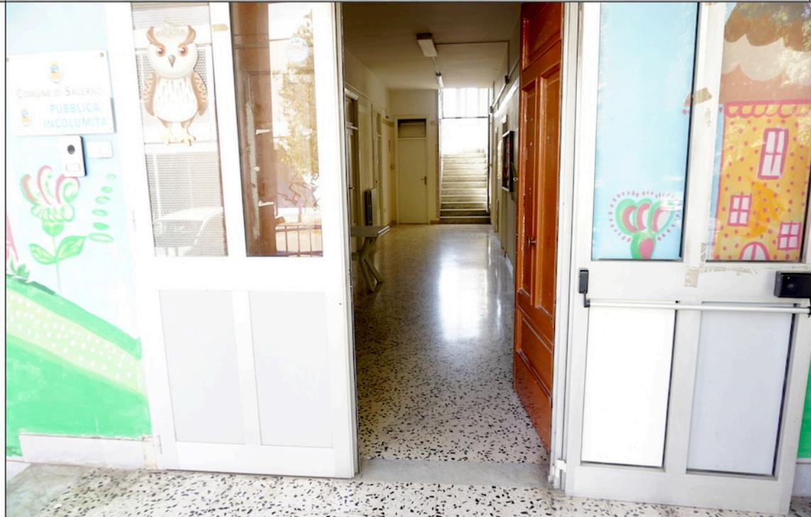
Assenza di sistema di chiamata esterno ad altezza accessibile dalla sedia a ruote
